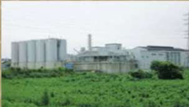
焼酎かすバイオマス発電設備
