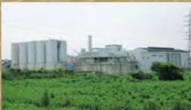
焼酎かすバイオマス発電設備
