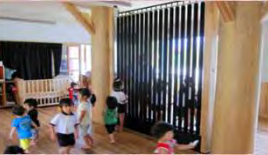
輻射式省エネ空調機器
