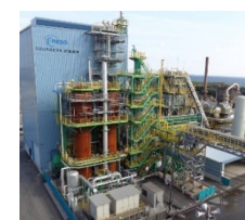
12m 3 小規模試験高炉(水素還元)
