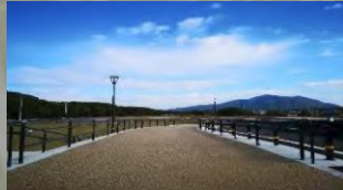
透水・保水性舗装骨材に再利用
