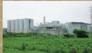
焼酎かすバイオマス発電設備
