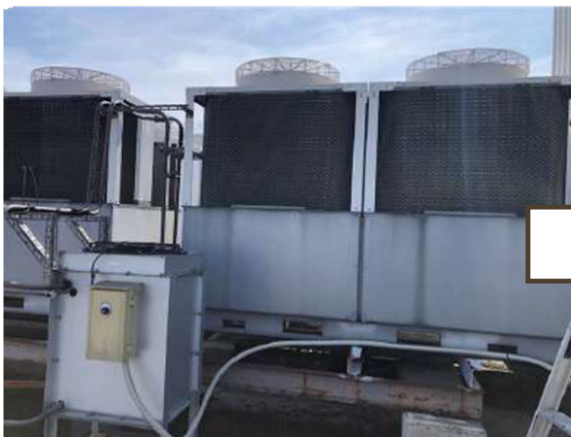
ファインペイント施工前
