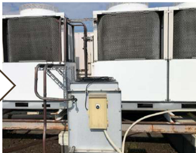
ファインペイント施工後
