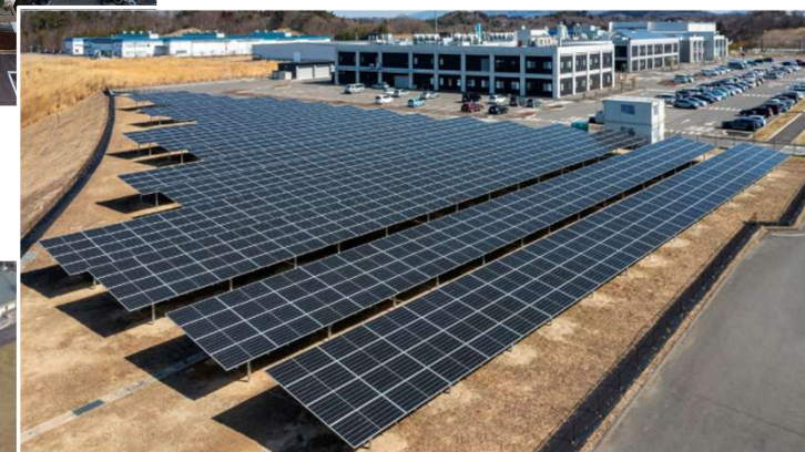
福島県（環境創造センター）
