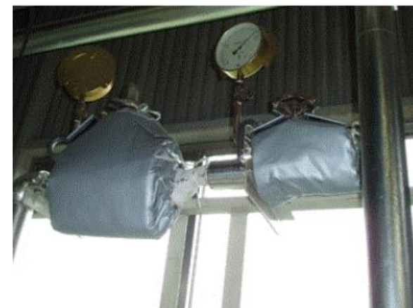
配管・バルブの断熱保温
