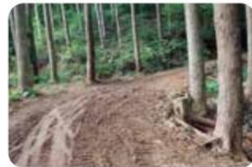
復旧した森林作業道
