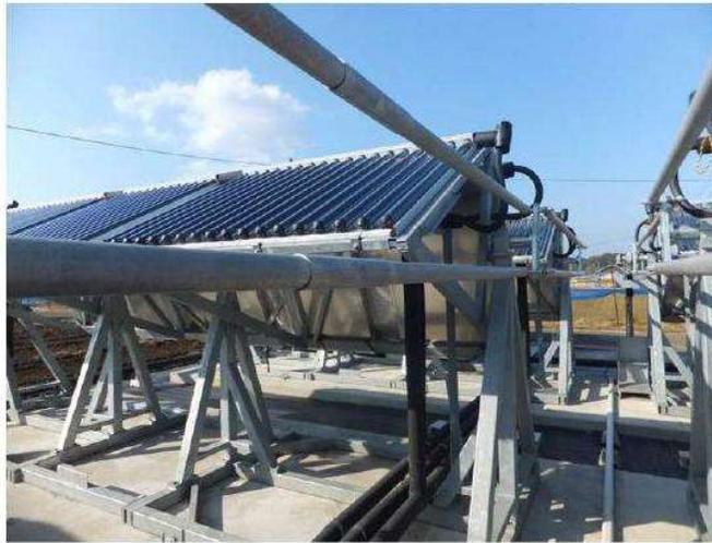
真空管式集熱器(角度調整架台)
