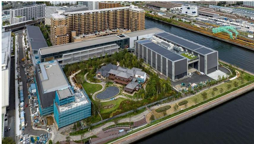
敷地内に設置されている太陽光発電や蓄熱槽などの熱源機器を1つのシステムとして統合制御し、敷地内の建物間で電力や熱を融通し合える仕組みを開発。AI(人工知能)を搭載した地域エネルギー管理システム(CEMS)を活用し、エネルギー利用の最適化を図っている。
