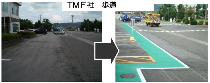
塗布2層塗り工法 H24.9.22施工 (工期：5Hr)
