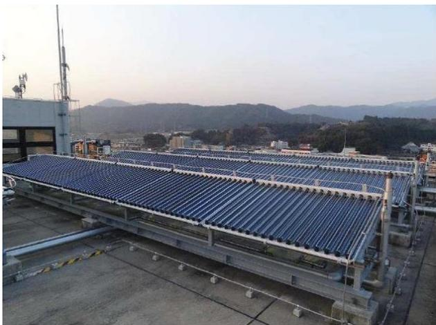
ソーラー吸収式冷温水発生機、空冷ヒートポンプチラー、太陽熱集熱パネル、マイクロコージェネレーションにより構成する複合熱源システム
