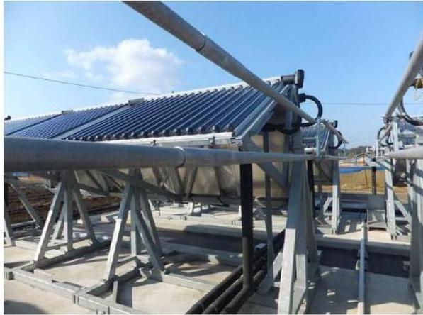
真空管式集熱器(角度調整架台)
