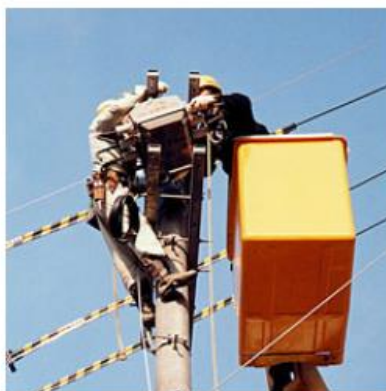
電気工事作業風景
