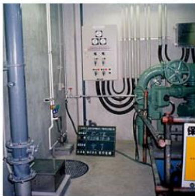
上水道ポンプ場計装工事
