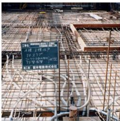
公営住宅一般電気工事
