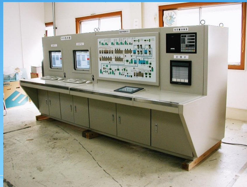
佐世保市西部クリーンセンター 最終処分場
