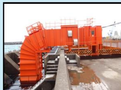
空気タービン式波力発電 （提供：エム・エムブリッジ）
