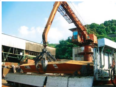
市中解体品受入れ
