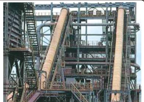
鉄鉱石破碎、篩分処理設備設計、施工
