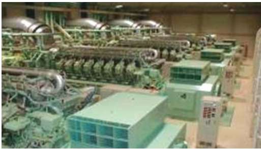
ガスエンジン
