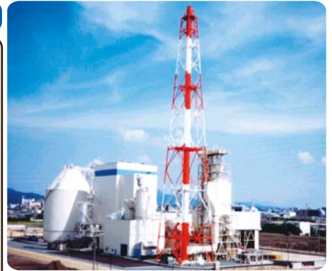
大牟田リサイクル発電所の全景
