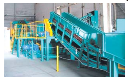
軟質廃プラ破碎・プレス設備 (2.5トン/時間)
