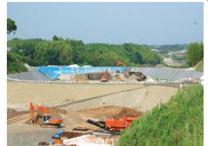
安定型埋立施設全景
