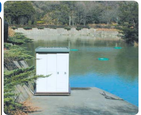
木炭活用水質浄化システムの全景
