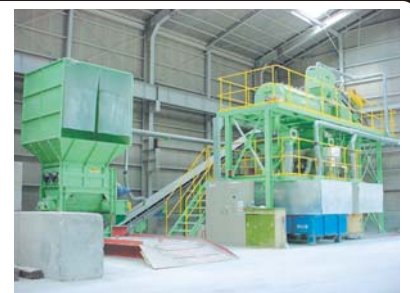
石膏ボードプラント
