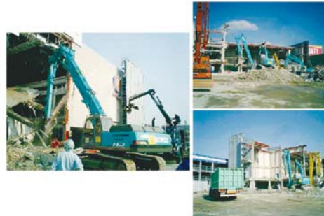
解体工事部門
