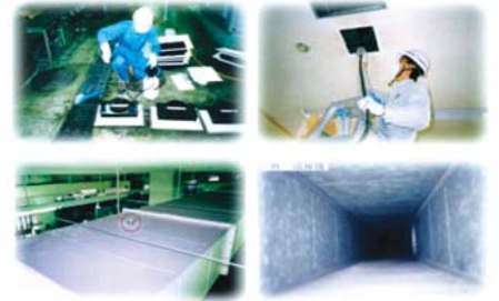
ダクトクリーニング作業
