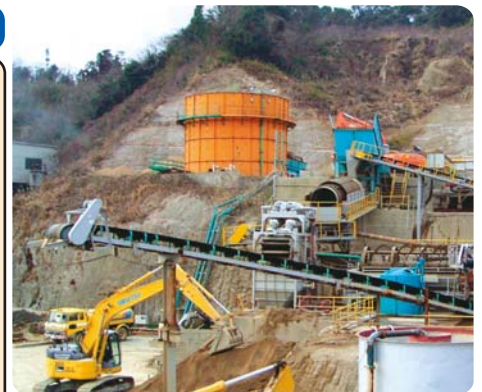
再生砂製造プラント
