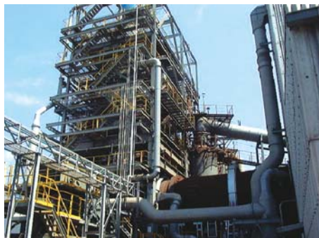
産廃焼却炉と2次燃焼炉
