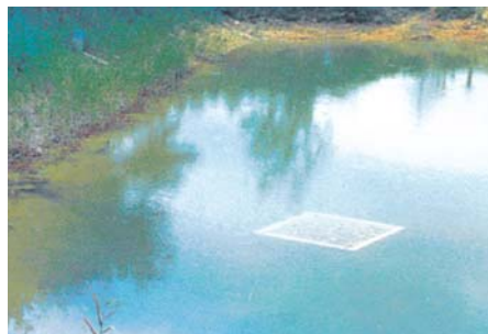
生物膜酸化法による木炭活用水質浄化システム
