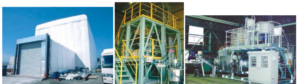
廃棄物焼却炉解体工事
