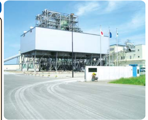
苫小牧発電所
