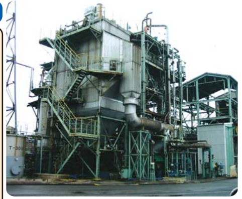
産業廃棄物の焼却施設
