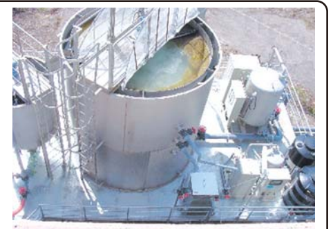
長崎県 ダムの浄化設備
