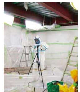
アスベスト調査
