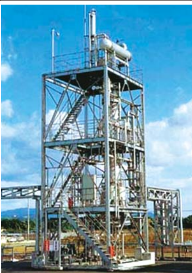
溶剤リサイクル事業/固液分離塔・蒸留塔
