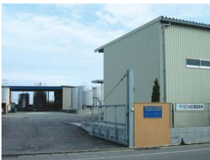
再生重油製造工場
