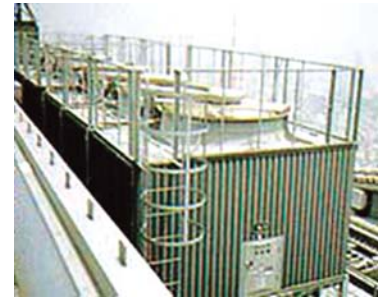
六本木ヒルズ殿納冷却塔 9,100RT
