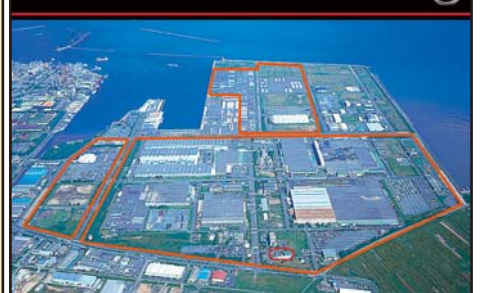
九州工場の全景
