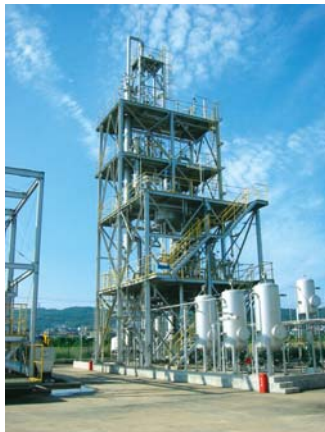
生ゴミ精製乳酸化実証施設
