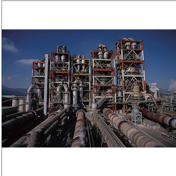
当工場(苅田地区)の焼成設備
