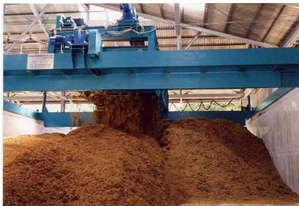
有機廃棄物堆肥化プラント
