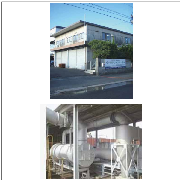
本会社屋 ロータリーキルン式焼却炉
