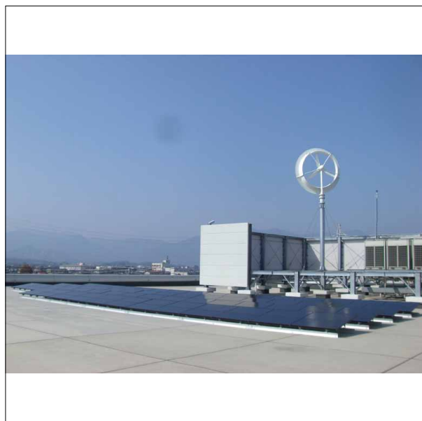
ハイブリッド発電実証システム (当社施設(行橋市)屋上)
