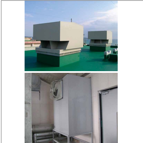
上:屋上設置換気消音器 下:壁面石器給気消音器
