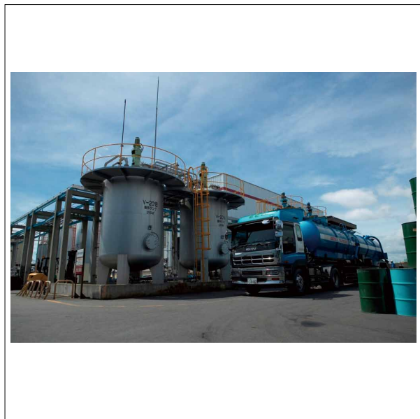
廃棄物を100%再資源化するアマタ姫路循環資源製造所
