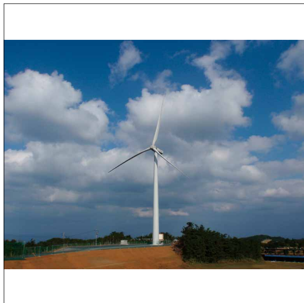
風力発電設備
