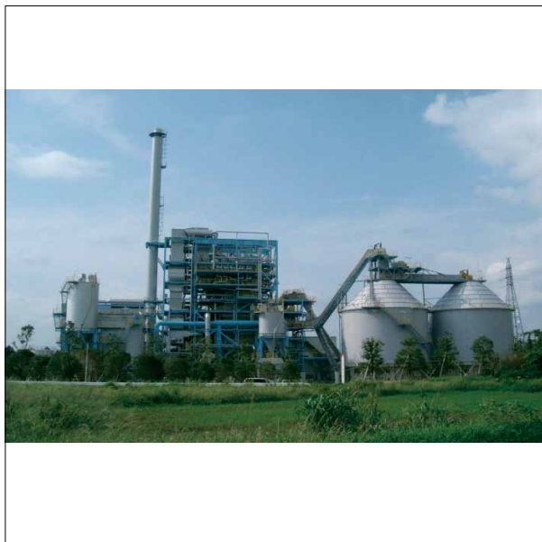
みやざきバイオマスリサイクル発電所
