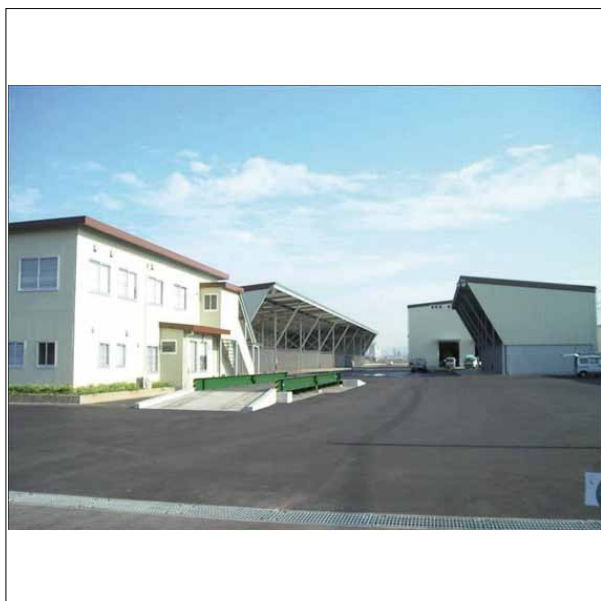
非鉄金属総合リサイクル／ひびき工場
