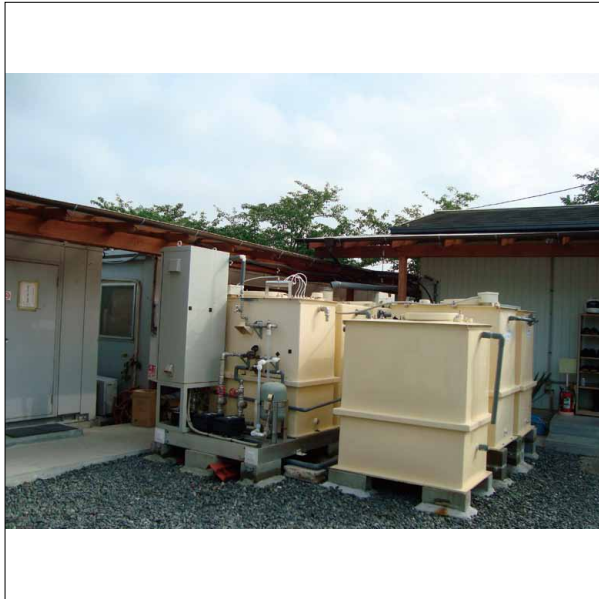
雨水を浄化して雑用水や飲料水に変える装置
