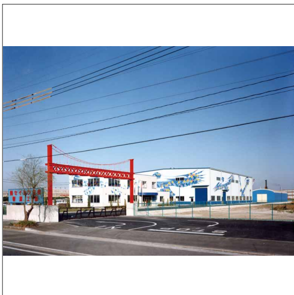
響灘工場 北九州市若松区のエコタウンセンターのそばです。
