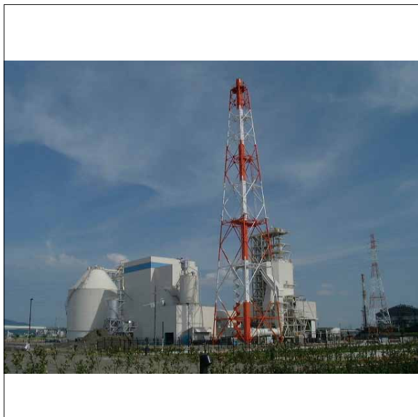
大牟田リサイクル発電所の全景
