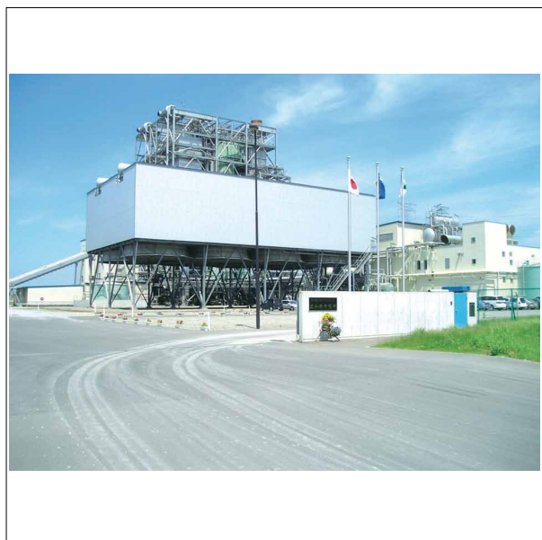
(株)サニックスエナジー苦小牧発電所
