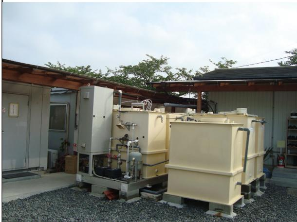
雨水净化转变成杂事用水和饮料水的装置
