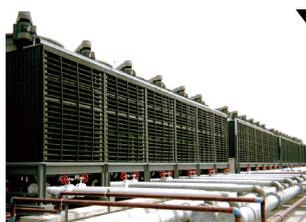
循环水在密闭回路中流动，不与空气直接接触。因此循环水不会发生浓缩或水质变化，容易控制。
