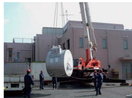
▲ 最新鋭MRI装置搬入据付状況
