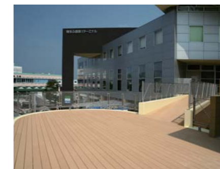
▲ デッキ施工実例「バイサイドプレイス」
