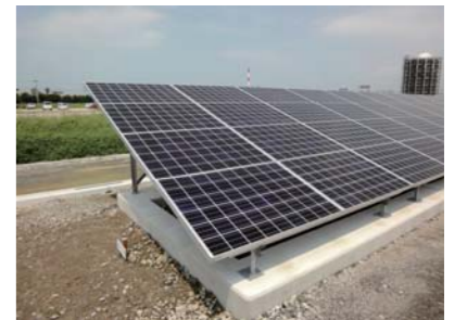
▲ 九州電力(株)殿メガソーラー大牟田発電所(3,000kW)
