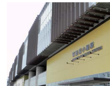
▲ ルーバー施工実例「筑後船小屋駅」
