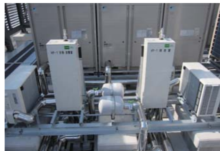
▲高効率ヒートポンプ熱源機
