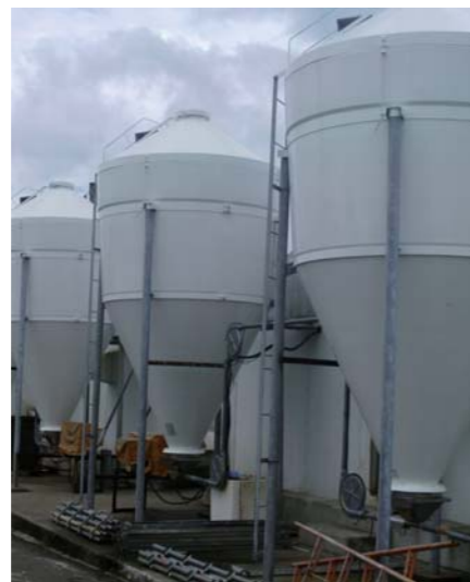
▲ 饲料槽的隔热粉刷
