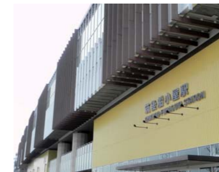
▲ 百葉窗施工实例“筑后船小屋站”
