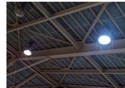
▲ 左边：水银灯 700W 右边：无电极电灯 250W
