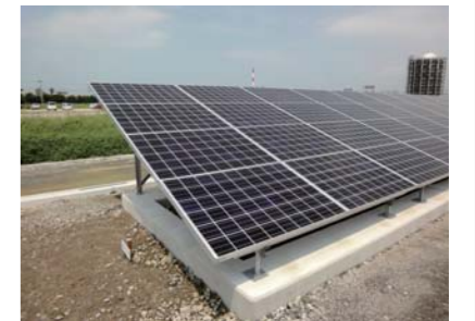
▲ 九州电力股份有限公司, MEGA SOLAR 大牟田发电厂(3,000kW)
