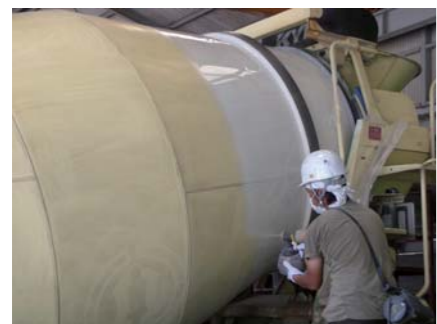
▲ 混凝土车滚筒的隔热粉刷
