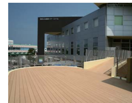
▲ 地板施工实例“Bayside Place”
