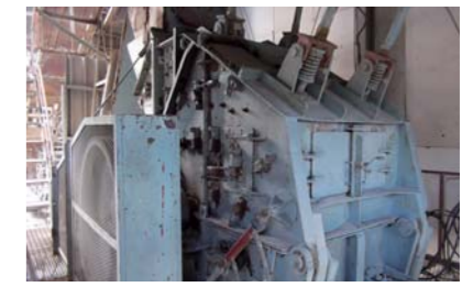
▲ 第二次破碎机 (Impact Crusher NCF-2B)
