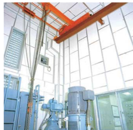
▲ 『IL Joiner』施工后
