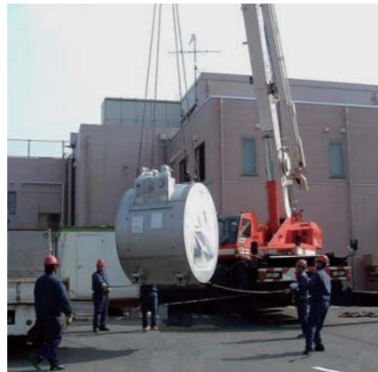
▲ 最新 MRI 装置搬入安装情况
