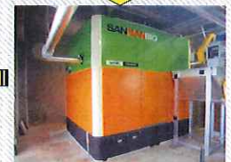
バイオマスボイラ
