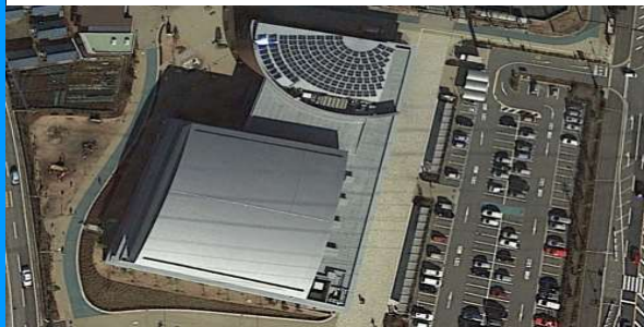
スポーツ施設 20パネル (静岡)
