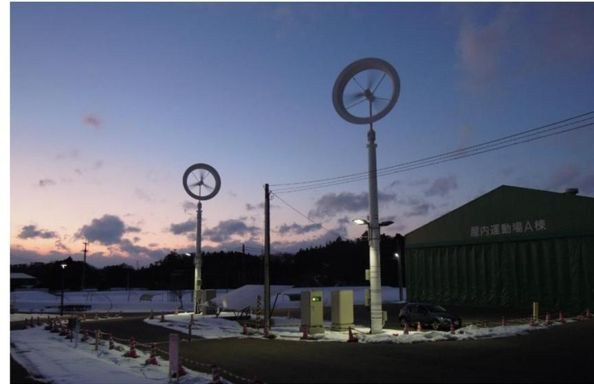
風力+太陽光で出力平準化・高稼働率を実現・東松島市
