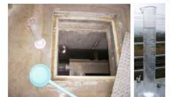
最終沈殿槽採取 ほぼ透明
