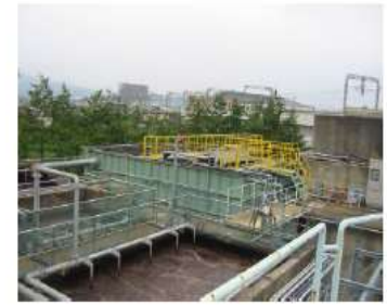
既設流用+鋼板槽
