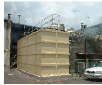
既設流用+鋼板槽
