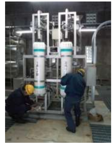
浄水施設メンテナンス
