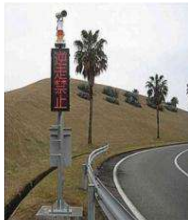
高速道路逆走防止装置
