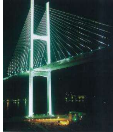
橋梁照明工事
