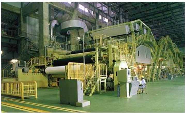
製造現場の様子（高岡工場 N1C/M）
