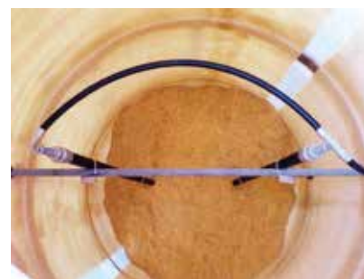
ホッパータンク内部の様子
