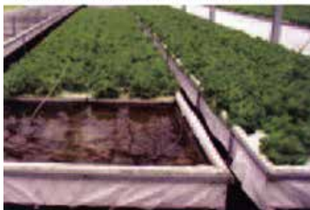
栽培用内に設置された冷却・加温パイプ
