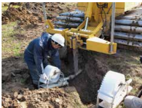
シートパイプ施工の様子
