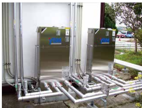
地中熱ヒートポンプ設置時の様子
