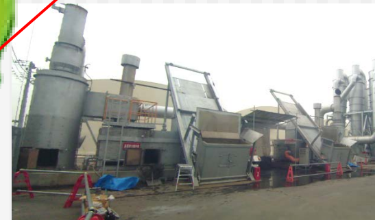
⑤宮城県石巻市 震災瓦礫の熱利用
