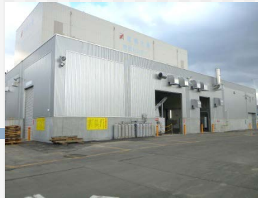
⑦北海道札幌市 蒸気ボイラ
