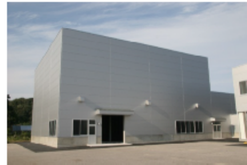
富山ものづくり研究開発センター(電波暗室棟)
